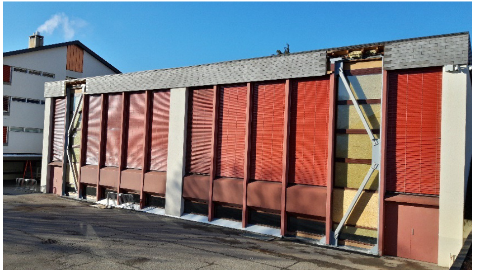
Salles de gymnastique – Travaux de renforts parasismiques en cours
