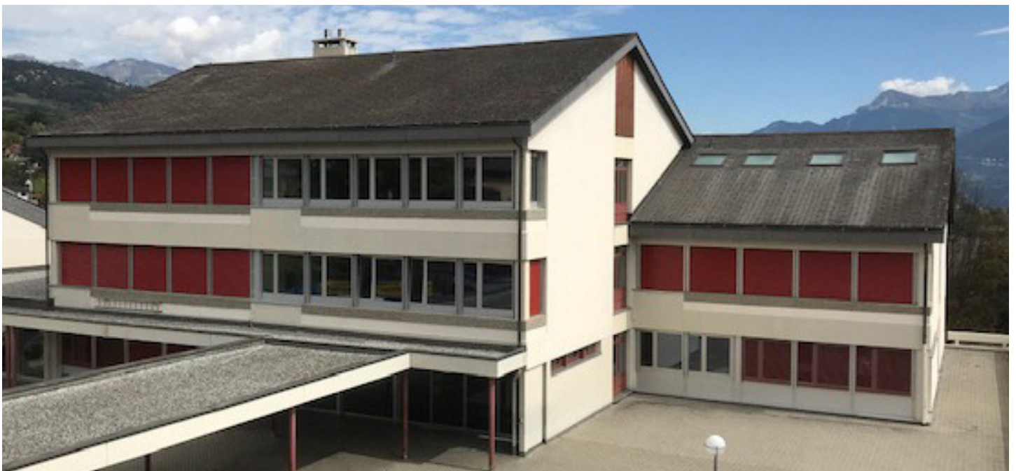
Bâtiment du Primaire – Travaux de remplacement des fenêtres
